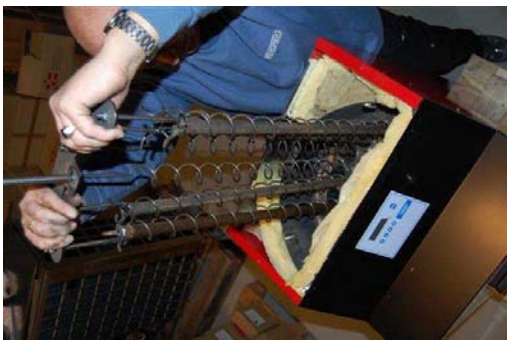
Fig.7 sænk rensesættet ned i røg rørene. Husk at fjerne strips når rensesættet er på plads.
