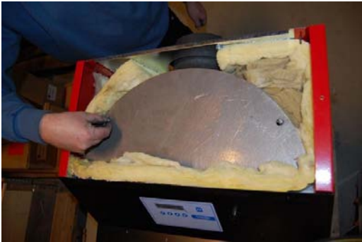
Fig.1 Kedlens top og Rensedæksel til røgkassen aftages. Hvis bøsning mangler, rekvirer nyt dæksel.
