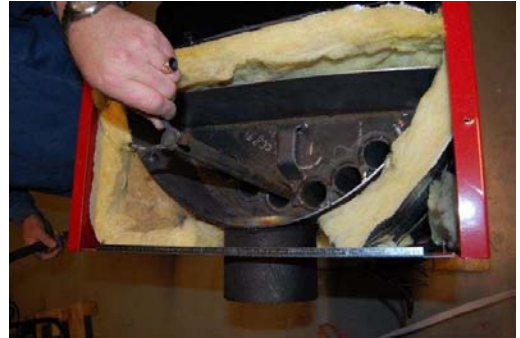
Fig.2 Udtag alle turbo-latorene (rør)
