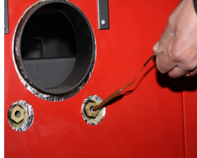
Overkogstermostat føler og kedelføler monteres.
