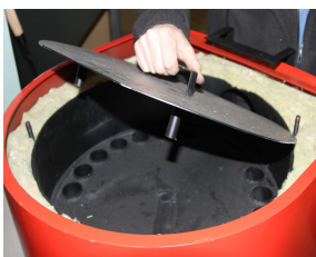
Topplade over røgrør. Man skal huske at rense under pladen.
