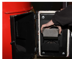
Herden monteres i holderen på lågen. Man skal huske at rense under herden.
